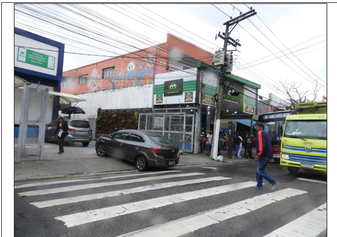
Foto 13 - Vista geral do imóvel, localizado na Av Comendador Sant' Anna, nº 542, inserido na porção Norte do futuro prolongamento da Linha 5 - Lilás do Metrô - Trecho Superfície. Observa-se que a consulta realizada na base de dados da Prefeitura de São Paulo, não apresenta restrições de uso. A base de dados da CETESB, não apresenta informações referentes ao gerenciamento de área contaminada no referido local, porém identifica-se o cadastro da empresa Nakashima Pinturas LTDA - EPP que utilizou a área para "Serviço de Pintura Eletrostática", com Licença de Operação (nº 33002107), emitida em 31 de outubro de 2005. Atualmente, nota-se que o imóvel apresenta uso de serviços de saúde, com o funcionamento da AMAE Capão Redondo.
